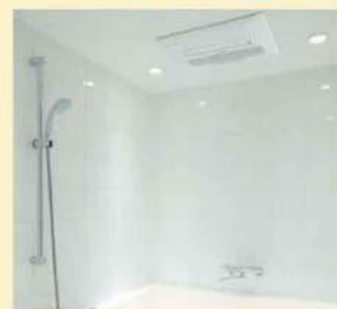
浴室暖房乾燥機
